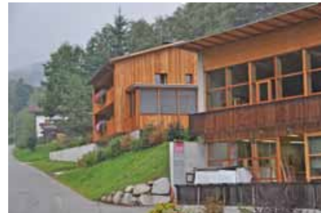
Durch die Baumaßnahmen am Haus wurde die Beziehung zur Werkstatt hergestellt.
